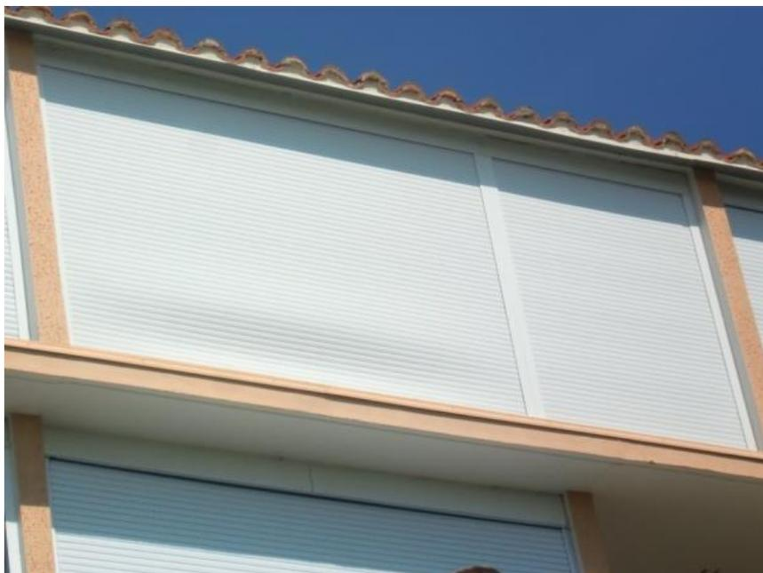
Figure 2 – Bombement du tablier d'un volet roulant
