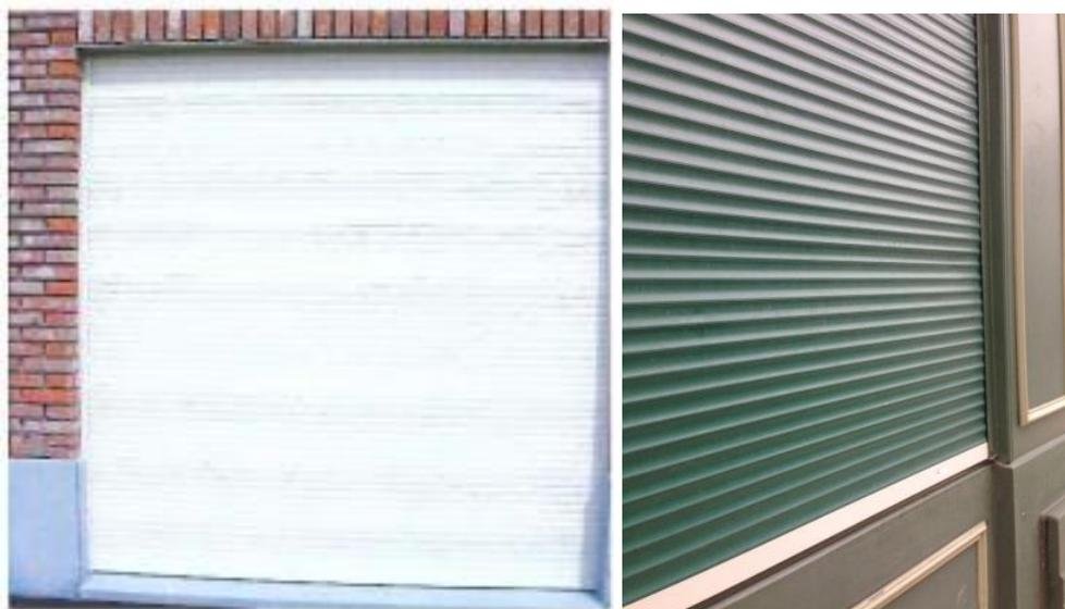
Figure 1 – Ondulation de tabliers de volets roulants
